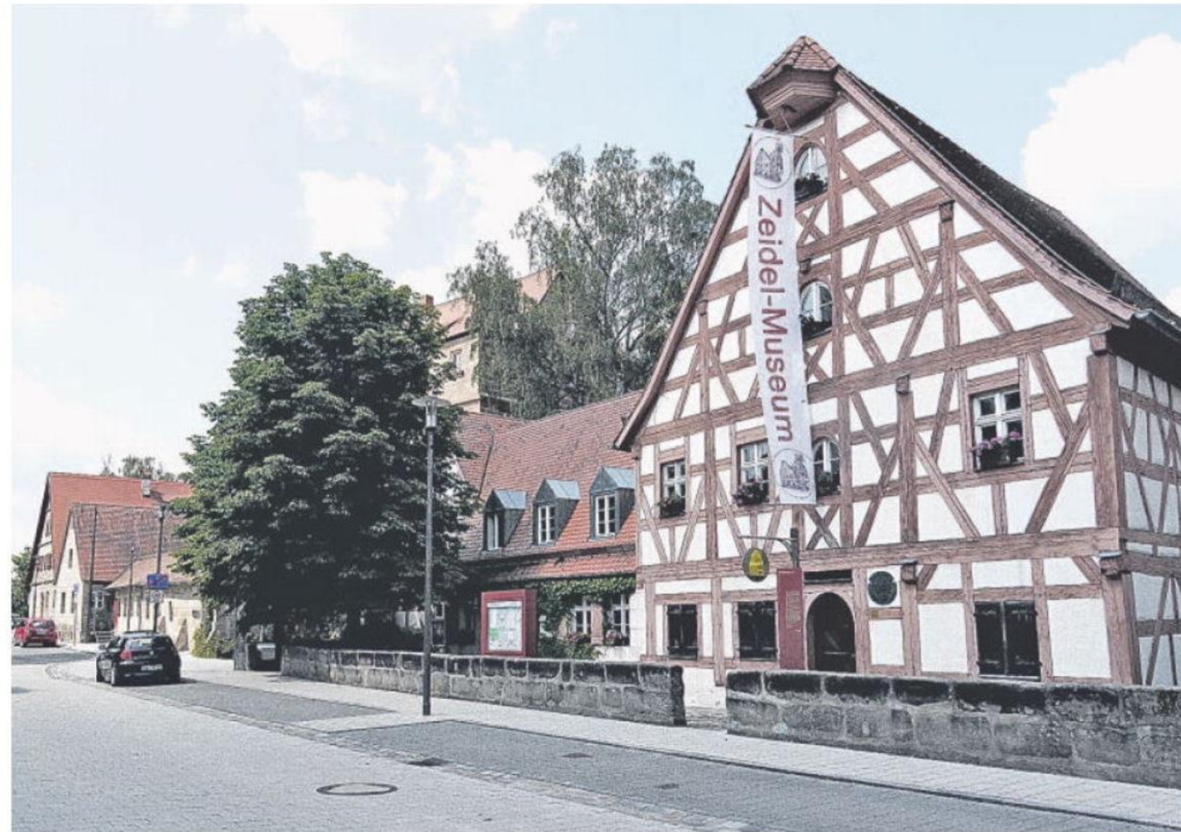
Darum geht's: Die Nutzung der Gebäude Zeidelmuseum, Bücherei, Raumfahrtmuseum und Pfinzingschloss soll neu geordnet werden. Foto: Spandler
